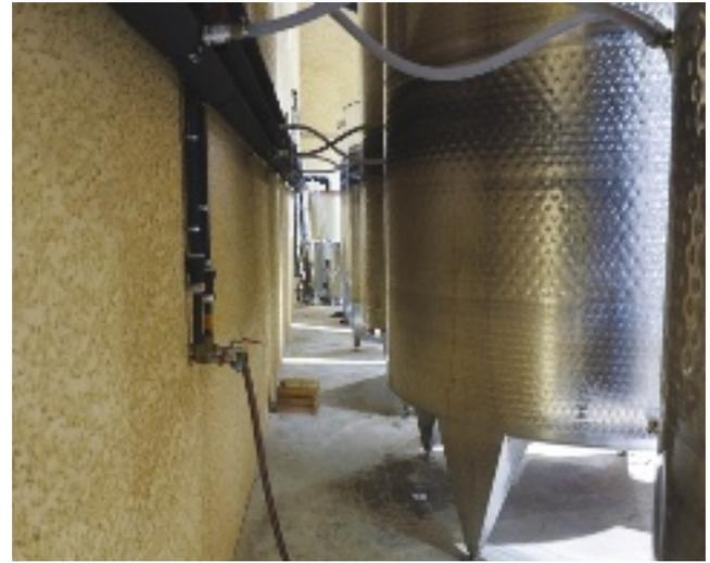
**À L'ARRIÈRE DES CUVES,** ce passage de 70 cm, laissé sur les conseils de l'ergonome Jacques Escouteloup, facilite le nettoyage.
