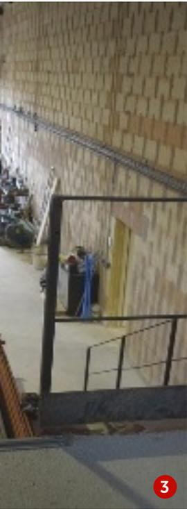
**3 LA MEZZANINE** est équipée d'une rembarde de sécurité, avec une partie mobile qui permet de gerber les palettes de matières sèches en haut.
